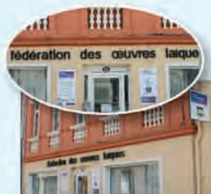
Elaboration et suivi des travaux de rénovation de la façade et signalétique extérieure.
